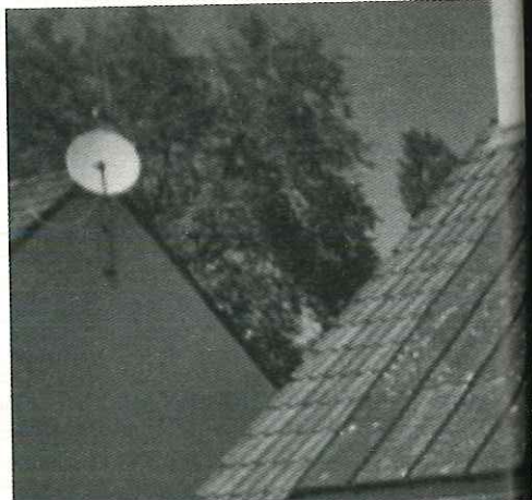
Installation solaire : photovoltaïque et therm
