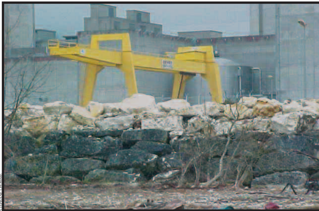
La digue censée protéger la centrale du Blayais a été submergée.
