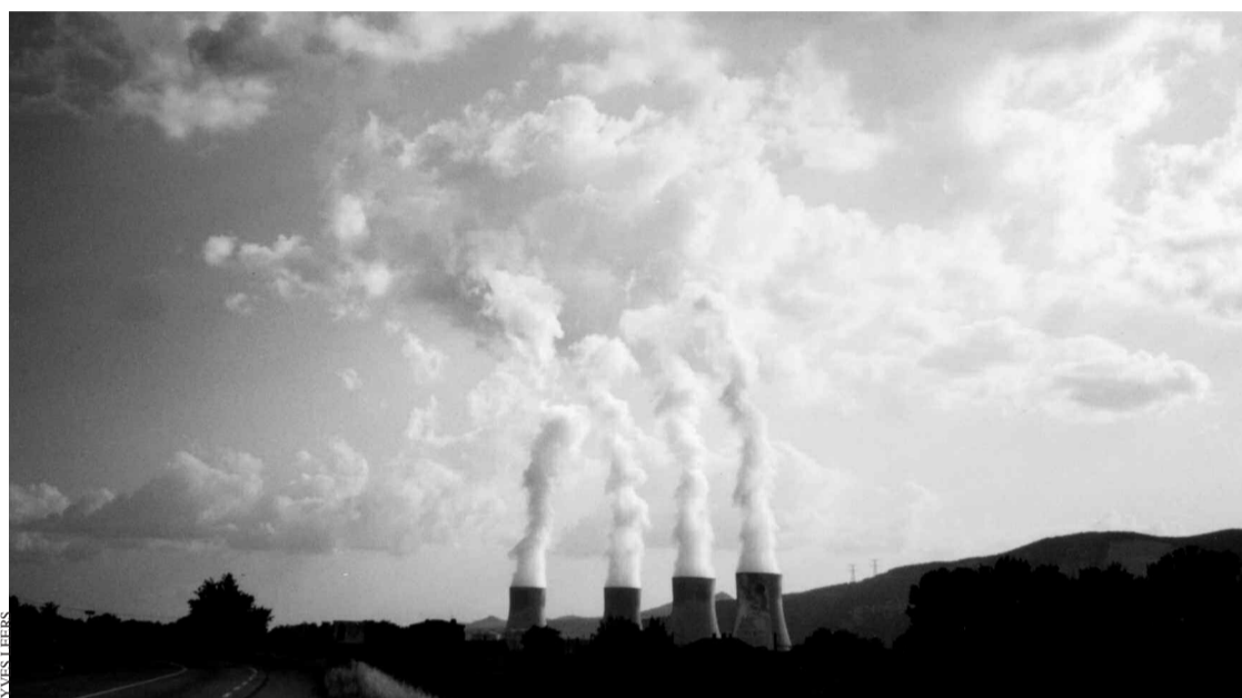
Lors de la conception des centrales, les constructeurs ne se sont jamais souciés de prévoir leur démantèlement.
