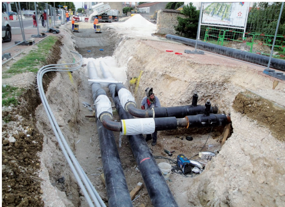
Construction d'un réseau de chaleur à Dijon.
