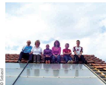
Toute la famille Loetscher avec son installation de 18 m 2 (en cours de construction) pour l'eau chaude sanitaire et l'appoint chauffage.
