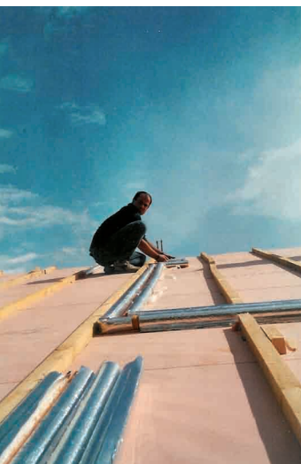
En plein chantier d'autoconstruction sur le toit d'une maison respectant la norme Minergie, qui consomme l'équivalent de seulement 2 litres de mazout par m 2 et par an pour le chauffage et l'eau chaude sanitaire. L'installation solaire thermique, intégrée sur un toit à 60° plein sud, couvre 55% des besoins restants.
