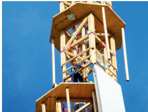
Un aperçu de la structure du mât en épicéa de la première éolienne Timber Tower.
