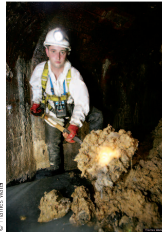
Danny Brackley, un égoutier de la Thames Water, ramasse des "fatbergs", ces icebergs de graisse qui encombreront le réseau d'égouts de Londres.
