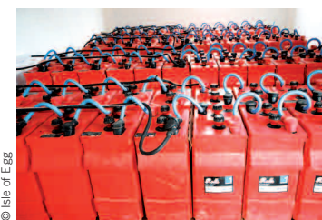
Les moyens renouvelables de production d'électricité d'Eigg sont reliés à une banque de batteries.
