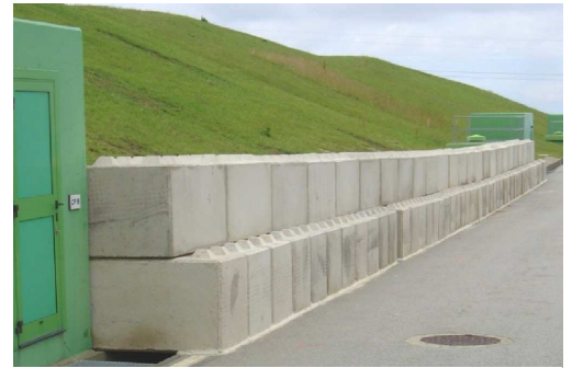
Photo : Blocs bétons de mise en sécurité des talus en zone est du site en juin 2007 (source ANDRA)
