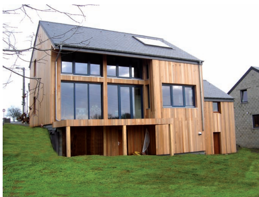
Une maison passive en cours de finition dans les Ardennes belges. Compacte et rationnelle, elle est en ossature bois. www.passive-aventure.be
