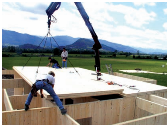
Les panneaux en bois massif sont fréquemment utilisés pour les maisons passives. Doc. KLH
