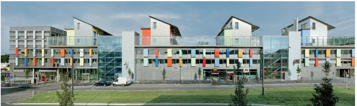
Le Solar Info Center est un milieu interdisciplinaire propice à l'innovation et à la croissance qui héberge 40 entreprises. Leur objectif est de démontrer qu'une réflexion raisonnée sur les ressources énergétiques n'est pas une utopie sous le prétexte d'être sans avenir économique.
