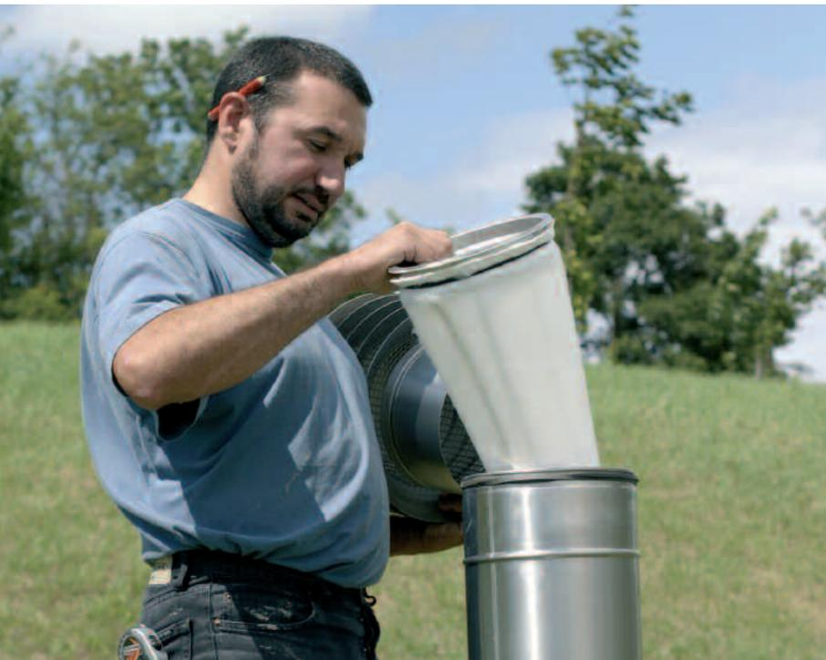
**Le filtre doit être régulièrement vérifié et nettoyé pour assurer un bon fonctionnement de l'installation.**
