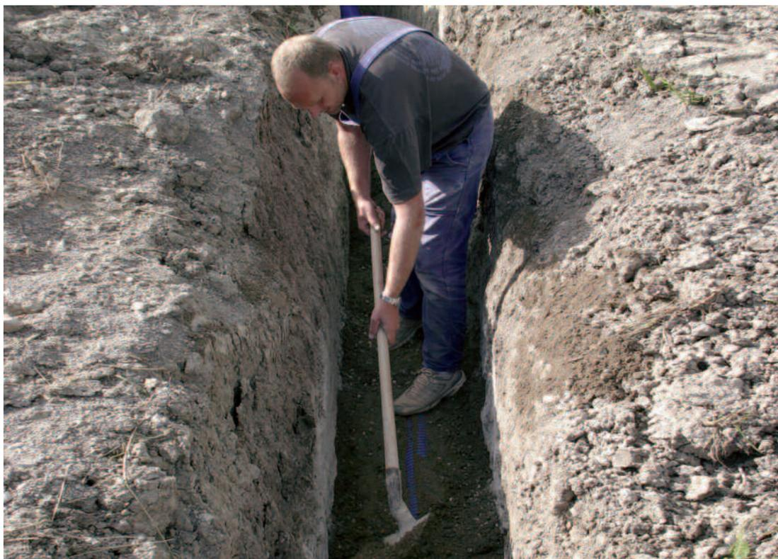
Le tuyau est enveloppé d'une couche de sable afin de ne pas le blesser, d'éliminer les poches d'air et de le maintenir en place lors du rebouchage de la tranchée.
