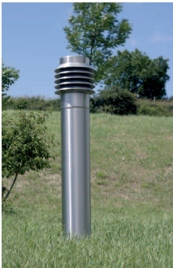
La tranchée est rebouchée, le puits canadien va pouvoir fonctionner dans son environnement protégé de l'extérieur. A l'extérieur, seule la présence de la cheminée trahit l'installation d'un puits canadien.
