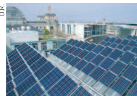
Installation photovoltaïque sur un ministère dans le quartier gouvernemental à Berlin
