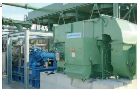
La génératrice produit l'électricité. On aperçoit la turbine derrière en bleu.
