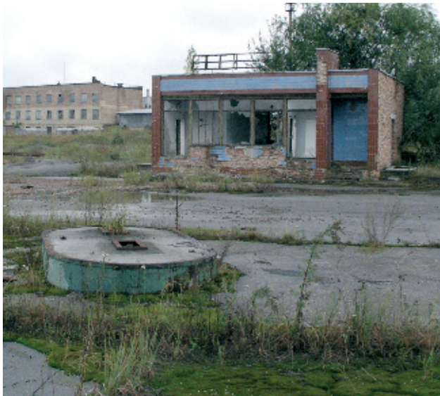
12h 32mn 29sec - Place de la gare routière de Pripyat
