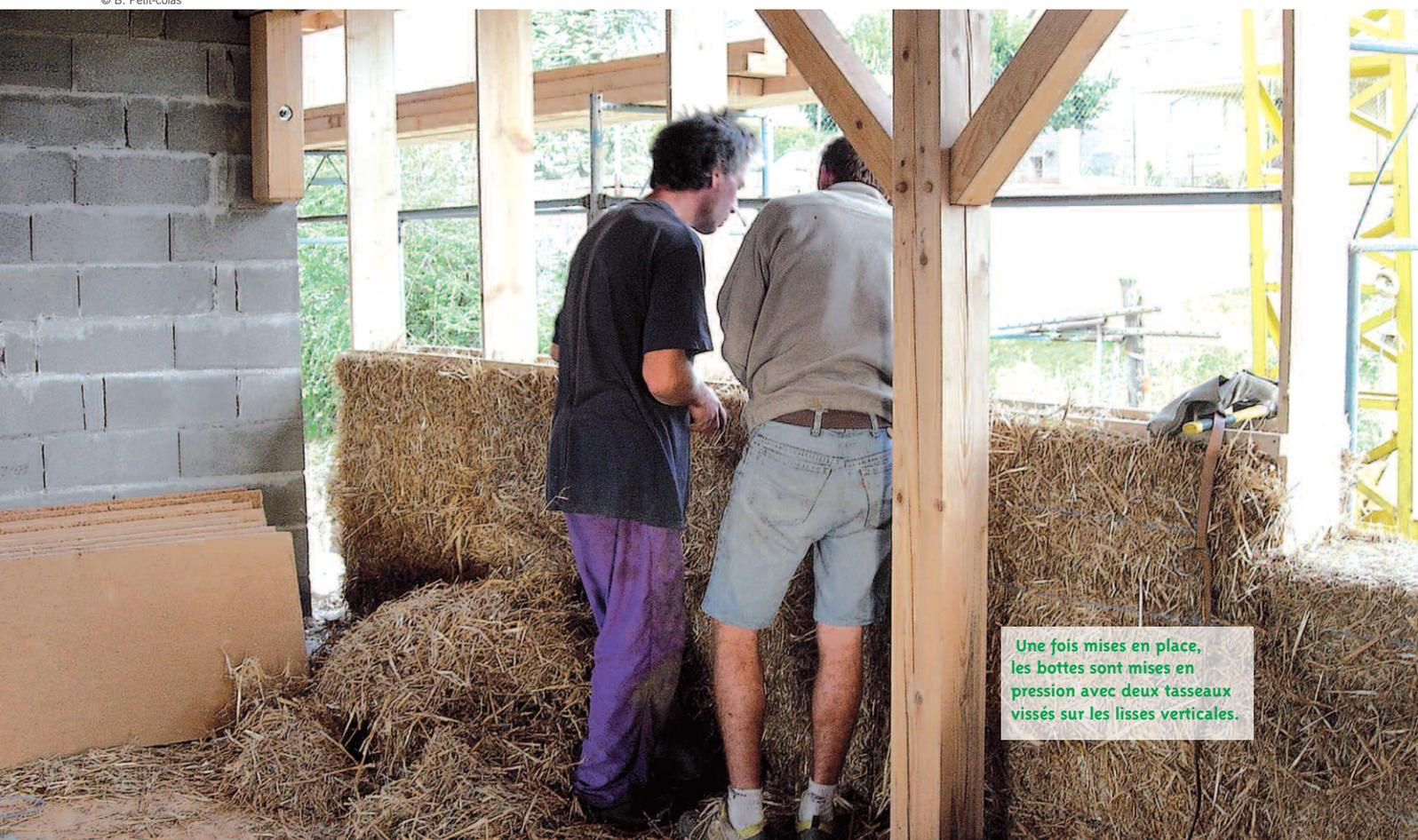
Une fois mises en place, les bottes sont mises en pression avec deux tasseaux vissés sur les lisses verticales.
