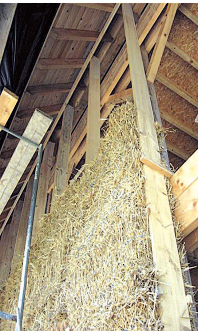
Le mur de bottes de paille se monte à l'extérieur de l'ossature entre les planches verticales.
