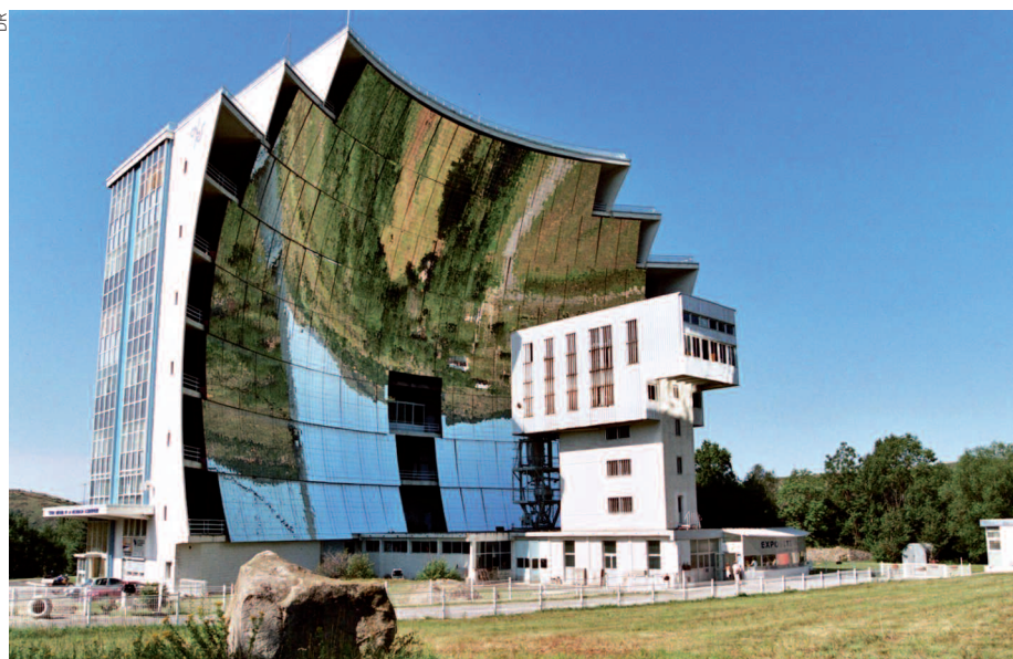
Le four solaire d'Odeillo (1 MW) dans les Pyrénées Orientales.
