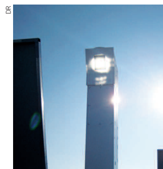
Une tour solaire à concentration.
