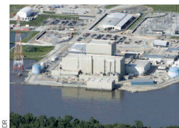
La centrale nucléaire de Cooper a également été inondée.
