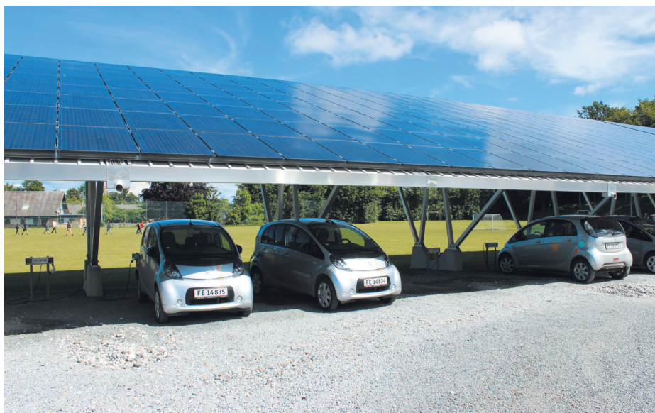
Structure de recharge des batteries de voitures électriques alimentée par des panneaux solaires
