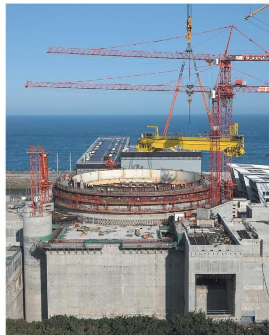
Le pont polaire de l'EPR (au moment de son installation) : cet engin de levage était dépourvu de système d'arrêt d'urgence, ce que les inspecteurs du travail de l'ASN ont dénoncé. Au lieu d'être remerciés, ils ont été blâmés par leur direction et le pont polaire a été utilisé sans ce dispositif de sécurité.
