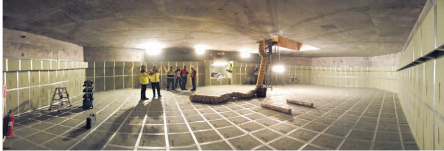
Sur cette photo, la mise en place des briques en fonte dans la chambre de récupération du corium est achevée. Elles seront ensuite recouvertes de béton "sacrificiel".
