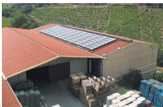
À Banyuls, depuis 1990, les caves à vin du GICB sont rafraîchies par une installation de froid solaire thermique.
