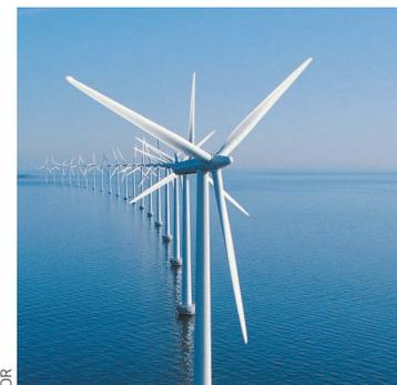
DR. La capacité d'une éolienne offshore est 50 % plus importante que celle d'une éolienne terrestre.
